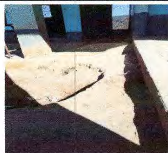
Foto 12: Reparación de banquetas de concreto (grosor 8 cm)
