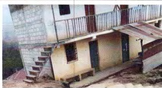
Foto 18: sustitución de barandas de madera por metal
