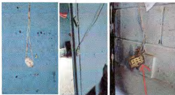
Foto 20: Reparación sistema eléctrico
