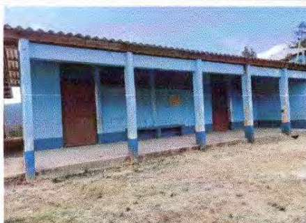
Foto 15: Pinturas en muros exteriores e interiores
