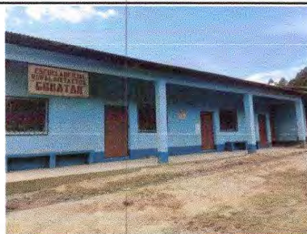
Foto 14: Pinturas en muros exteriores e interiores
