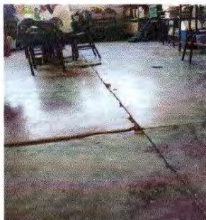
Foto 9: Reparación de piso de cemento liquido (grosor 4 cm)
