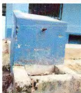
Foto 17: Sustitución lavamanos. Reparación de red de drenaje y agua potable
