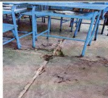
Foto 10: Reparación de piso de cemento liquido (grosor 4 cm)
