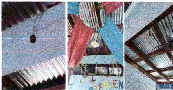
Foto 21: Reparación sistema eléctrico
