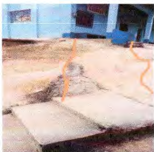
Foto 13: Reparación de banquetas de concreto (grosor 8 cm)
