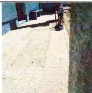
Foto 11: Sustitución de piso de granito
